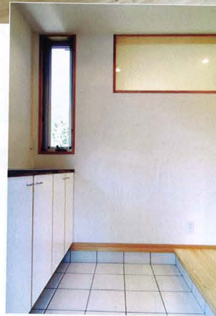
玄関の上がり框の例、このように木材の端部をできるだけ薄く見えるように納めると、軽快な印象になる
